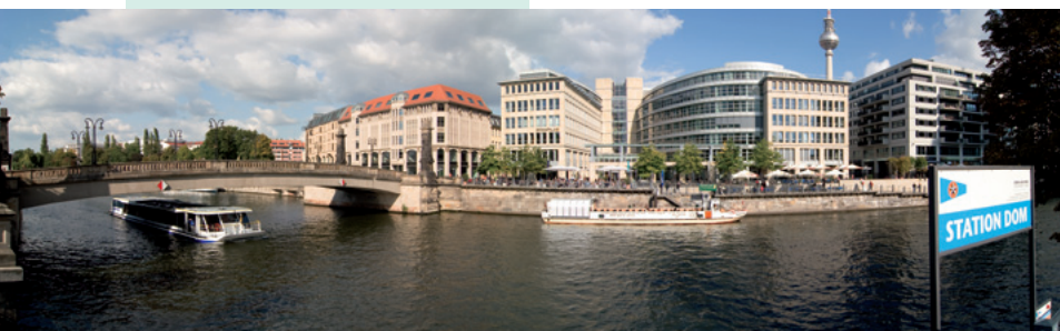
Die Geschäftsstelle des Fraunhofer-Verbunds Mikroelektronik befindet sich in der Mitte Berlins, im SpreePalais am Dom. Foto: Fraunhofer Mikroelektronik / Kracheel
