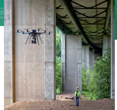
Der Hightech-Miniflieger scannt Bauwerke in wenigen Stunden. Foto: Uwe Bellhäuser
