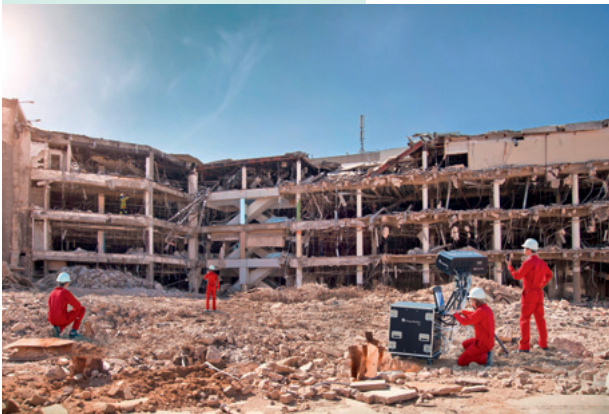
Eingestürzte Gebäude nach einem Erdbeben: Ein typisches Einsatzszenario des geplanten RAWIS-Systems. © Fraunhofer FHR / Uwe Bellhäuser
