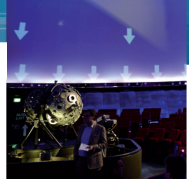
Hinter der gesamten Kuppel und rund um die Zuhörer wurden insgesamt 60 Lautsprecher und vier Subwoofer installiert (siehe eingeblendete Pfeile). Foto: Shure Distribution GmbH / Jens Rothenburger
