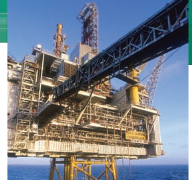
Erstes Anwendungsfeld der neuen Technologie ist die Fernwartung von Ölplattformen. Foto: MEV Verlag
