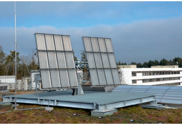
CPV-Solartracker auf dem Dach des Fraunhofer IIS Testzentrums L.I.N.K. © Fraunhofer IIS
