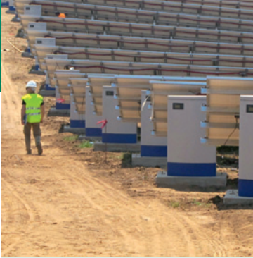
Wechselrichter der KACO new energy GmbH in einem Solarpark in Südtalien.
