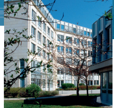
Das Gebäude des Fraunhofer ESK. Foto: Fraunhofer ESK
