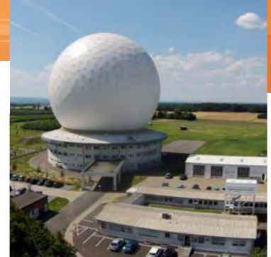
Das Weltraumbeobachtungsradar TIRA des Fraunhofer FHR in Wachtberg. © Fraunhofer FHR
