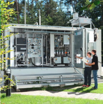
Mitarbeiter des LZE-Projekts diskutieren den kompakten verfahrenstechnischen Aufbau des innovativen Energiespeichersystems. © Kurt Fuchs / Fraunhofer IISB
